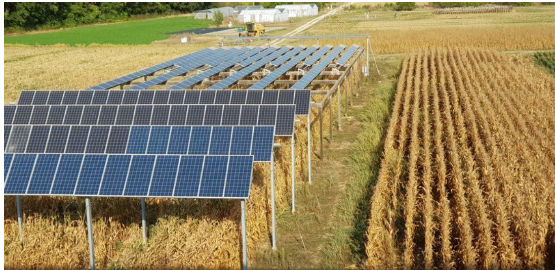
Granjas agri-fotovoltaicas: co-desarrollar misma área de tierra tanto para la energía solar fotovoltaica como para la agricultura.
